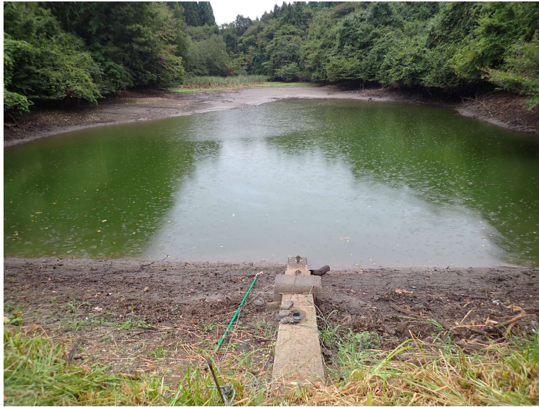
土砂吐がなく土砂の堆積が見られる
