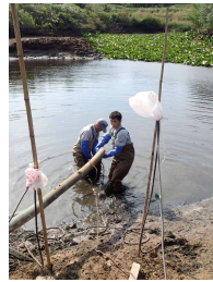
水中ポンプの移動作業
