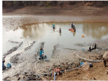
吸水口まで泥の掘削
