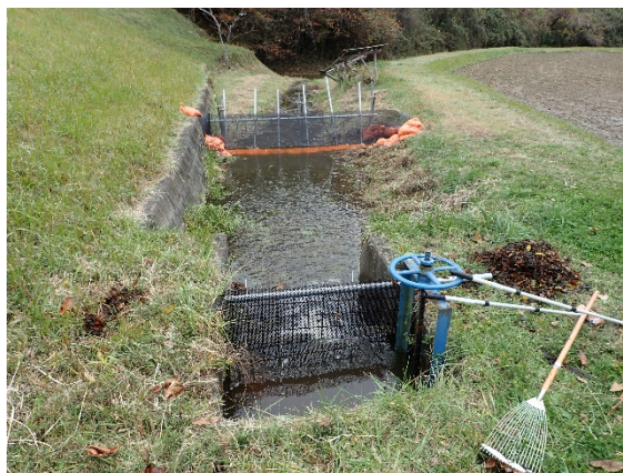
写真1 流下防止網の設置状況
