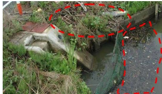
写真 38：取水部周辺の土砂やゴミの堆積
