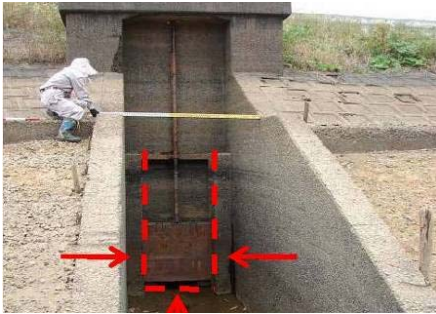
写真 37：ゲート周りの漏水
