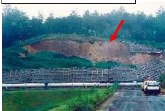
写真 41：堤体付近の法面（崩壊後）
